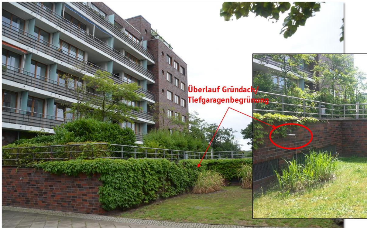
Abbildung 16: Ausführungsbeispiel Regenwasserkaskade (Rummelsburger Bucht)
